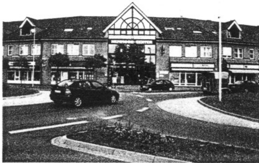
Hemmoor Center – Zentrumstraße
